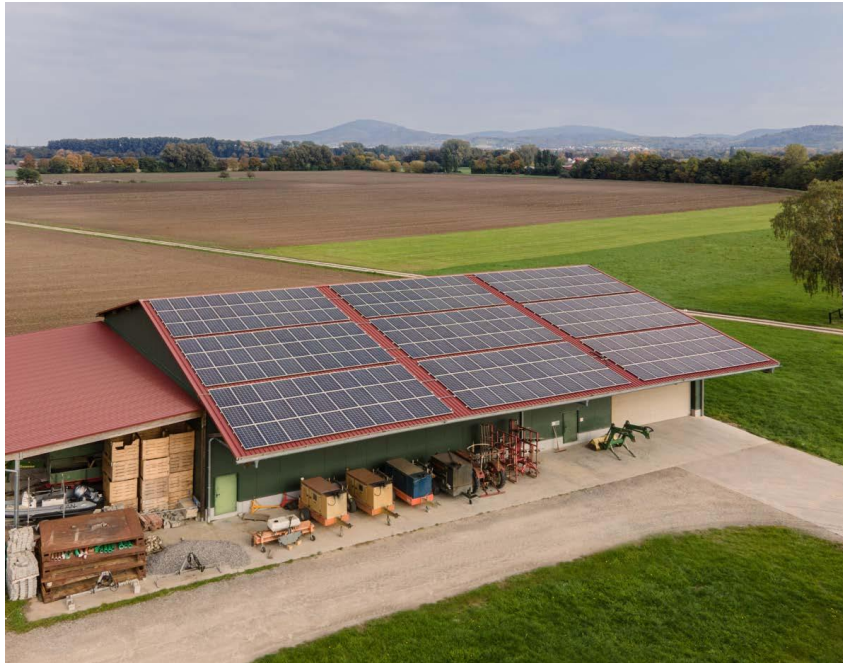
Bild zeigt PV-Systemhalle von Haas © Haas Fertigbau GmbH
